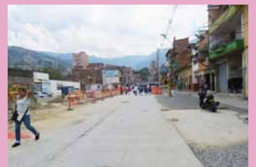
Avance de obra junto al Más Cerca.
