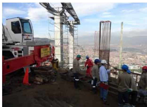
El metrocable línea M tendrá 11 pilonas en total. Este cable estará listo en el primer trimestre del 2016. El brazo de la grúa se extiende hasta 52 metros.
