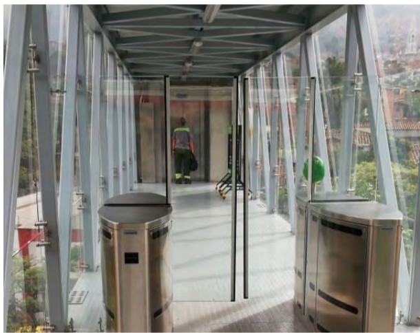
Los ascensores permiten un acceso ágil y cómodo a la estación.
