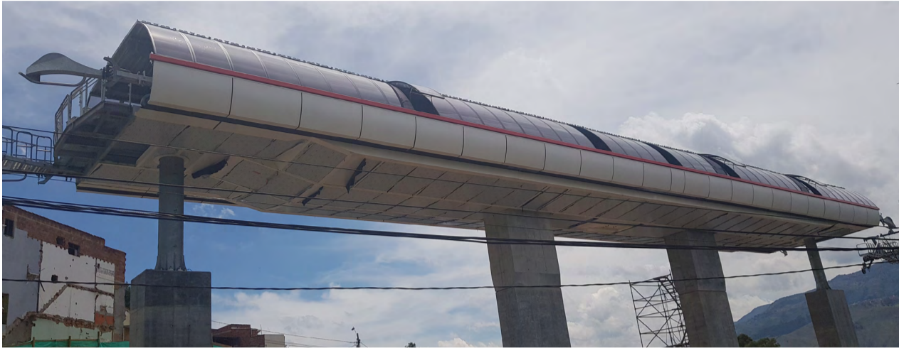
Imagen actual de la estación Doce de Octubre, será la segunda estación intermedia del cable.
