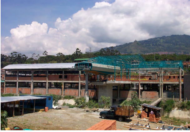
Imagen del costado norte de la estación Acevedo de Metrocable
