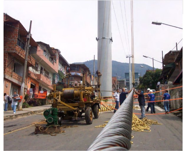
Izaje del cable portador tractor sobre la Calle 107.
