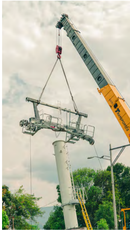
Se instala la cabeza de la piona sobre el fuste.
