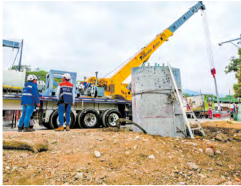
El primer paso es el vaciado del pedestal de concreto que sostendrá la piona.
