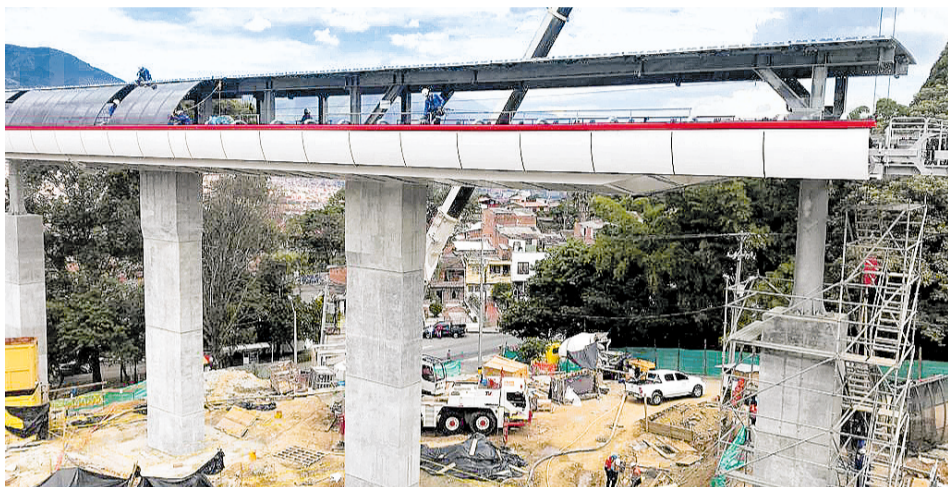
Imágenes de la instalación de la cubierta electromecánica en la futura estación Doce de Octubre, que será la segunda estación intermedia de la Línea P.
