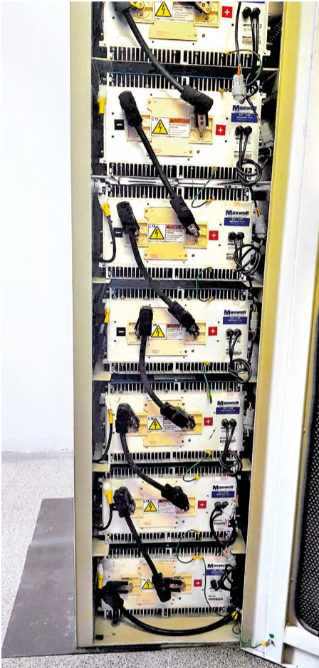
Ultracapacitores que almacenan la energía del frenado de los trenes. La energía se entrega luego a la catenaria para ser usada por otro tren.
