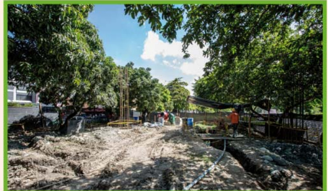
Así avanzan las obras en el costado occidental donde llegará la pasarela y habrá una pequeña plazoleta.
