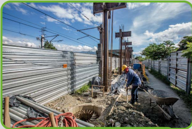
Poco a poco se levantan las estructuras metálicas que soportará el futuro edificio de la estación.
