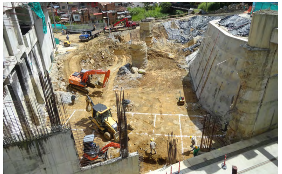
El muro del costado oriental de la estación Miraflores ya fue terminado. Las otras dos estaciones de esta línea ya están construidas.
