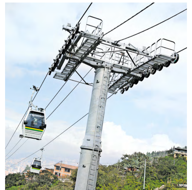
La línea H, uno de los cables complementarios del tranvía de Ayacucho, comenzó su operación el 17 de diciembre de 2016.
