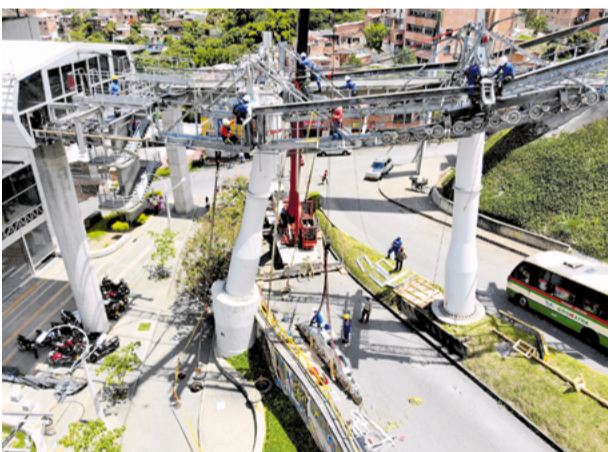
Cerca de 40 personas realizaron las labores de mantenimiento de los cables.
