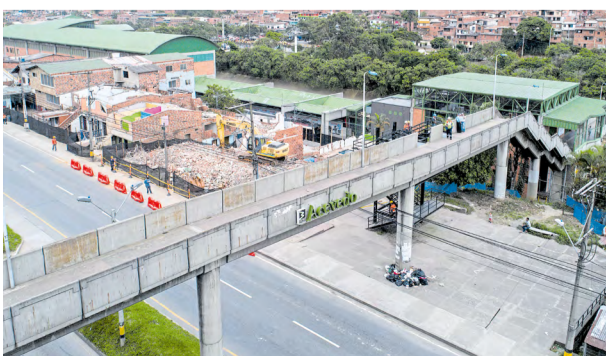
Así luce hoy el costado sur de la estación.
