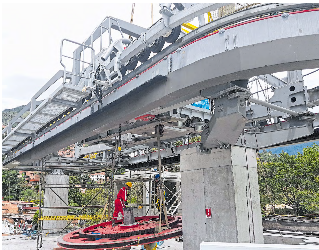
Así avanza el montaje de los equipos que permitirán impulsar las 49 cabinas del futuro Metrocable.
