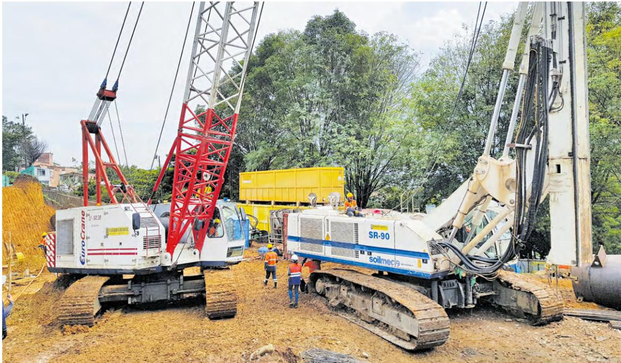
Con la intervención de esta maquinaria (derecha), se pretende tener un mayor rendimiento en la construcción de las pilas.
