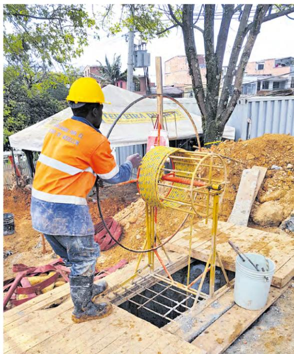
Algunas de las pilas se deben realizar de manera manual, es decir, con excavaciones realizadas por pileros.
